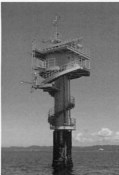
写真-1 田辺中島高潮観測塔
