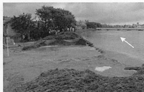
図－6 足羽川左岸福井市春日1丁目付近での破堤の状況（2004年7月18日14:30頃、国土交通省近畿地方整備局）
