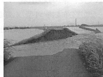
図－8 堤防決壊の状況（決壊箇所下流側から撮影：矢部川堤防調査委員会，2013）
