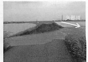
写真-9 矢部川 7k300 付近堤防決壊状況
