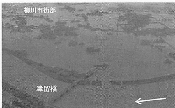
写真-8 矢部川 7k300 付近堤防決壊状況
