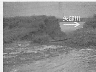
写真-9 矢部川 7k300 付近堤防決壊状況
