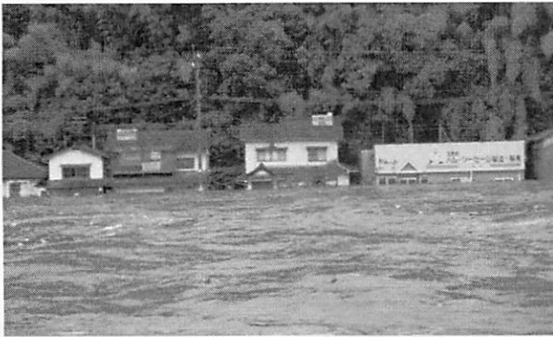
写真-4 山国川 15k800 付近（樋田地区） 浸水状況（7月3日）
