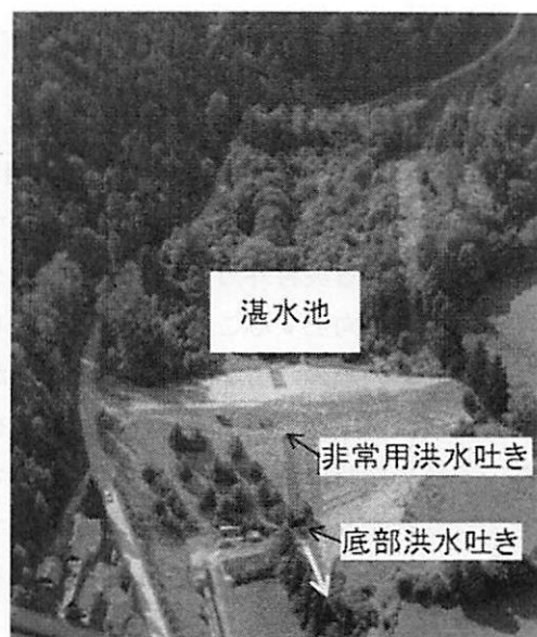
図-11 オーストリアの流水型（穴あき）ダム
