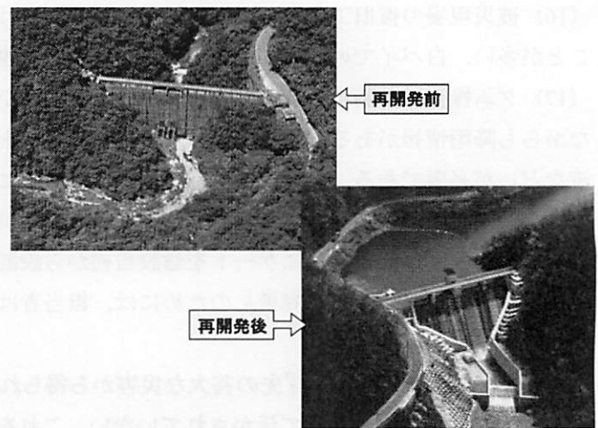
図-9 流水型ダムから貯水ダムへの転換 (島根県の笹倉ダム)
