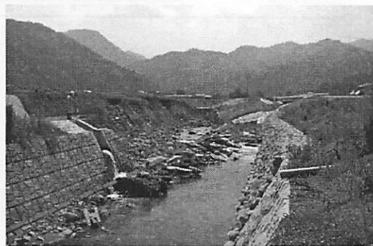
写真-2 河床掘削時に岩が露出した河川
