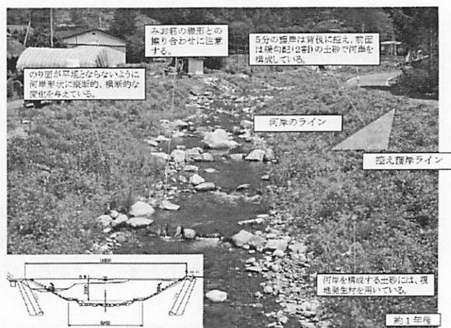
写真-3 護岸を控えて全面に自然河岸を造成した例 (岩手県元町川)
