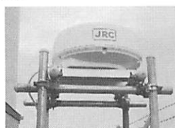
(c) レドームに収められた小型レーダ(大きさ約 0.6 m)
