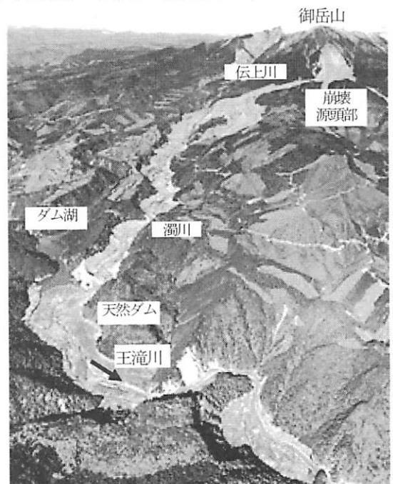
図－1 1984年の長野県西部地震による御嶽山の崩壊と王滝川にできた天然ダム（林野庁HPの写真を引用）
