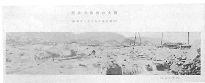
図－４ 阪神大水害の際の都賀川の被災状況 2)
