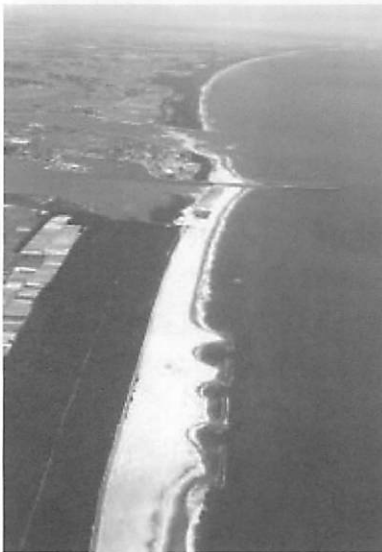
Fig.2-5 荒浜漁港の導流堤と阿武隈川河口（2008年国土交通省撮影）
