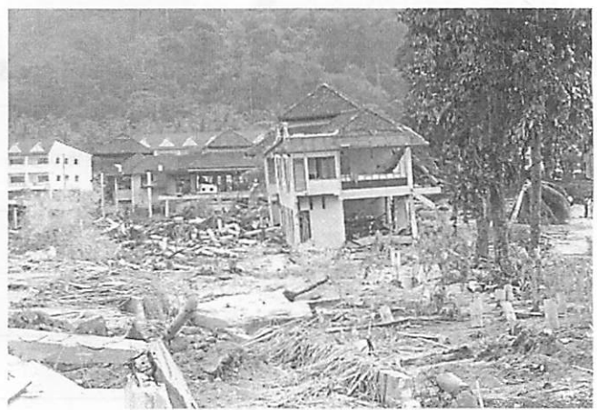
写真-4 壁や一部の柱が壊れ、地盤浸食により傾いた建物（タイ Khao Lak, 2004）
