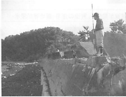
老朽化に伴う海岸保全施設の破損(岩手県玉川海岸)
