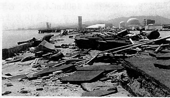
写真-3 広島廿日市における護岸破壊
