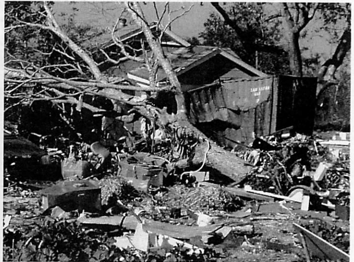
写真-6 漂流したコンテナの民家への衝突状況
