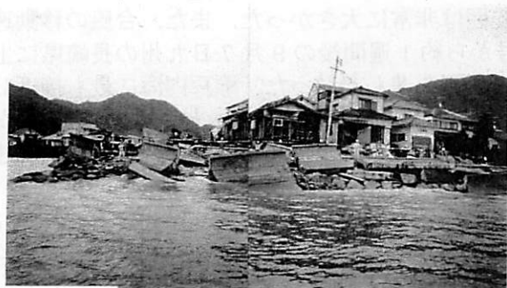
写真-2 呉における護岸破壊による家屋の被害
