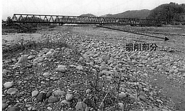
図-50 出水後の中州掘削箇所の礫床化
