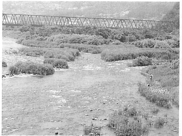
図－1 渡良瀬川礫床区間の風景(砂礫州の植生化)
