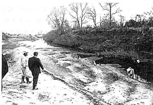
写真 4.4 千曲川中州掘削部に生じた砂堆
