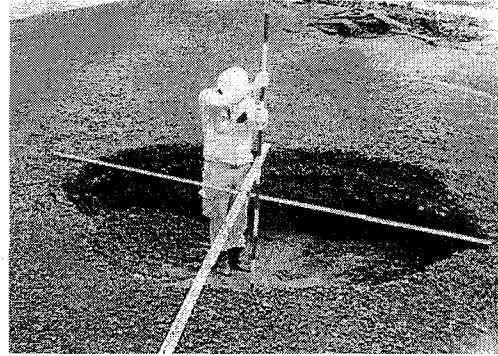
図23 護岸背後の吸い出しによる埋立地盤の陥没(高橋ら, 1996)
