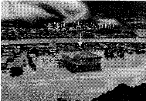
写真-7 避難所の浸水状況
