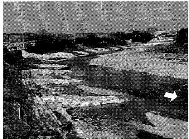
写真-7 捨石水制とその周辺の様子(出水後)
