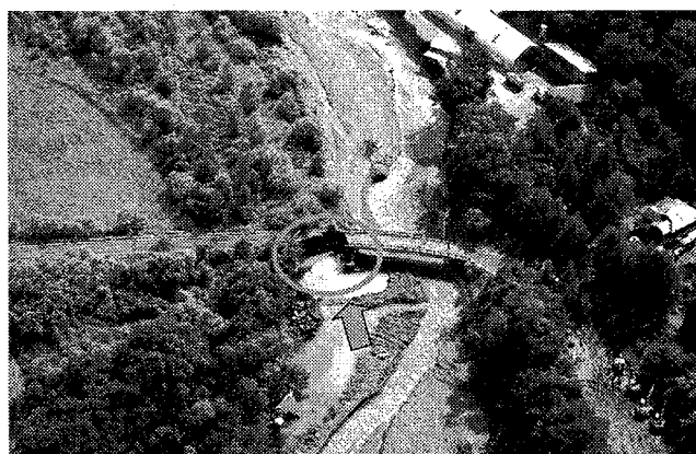
写真-9 流木による河道閉塞のため橋台背後が侵食された例（北海道居辺川居辺橋、2003 年の北海道水害時）
