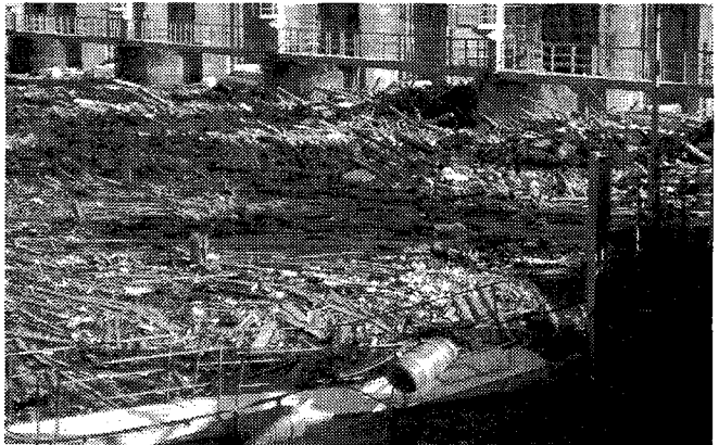
写真-2 大内原ダムの洪水吐き前面に集積した大量の流木（右岸側から堤体側を撮影）
