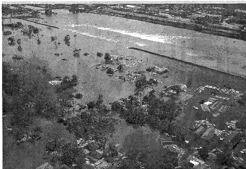
写真3-1 工業運河における破堤状況 (写真提供：米国陸軍工兵隊)
