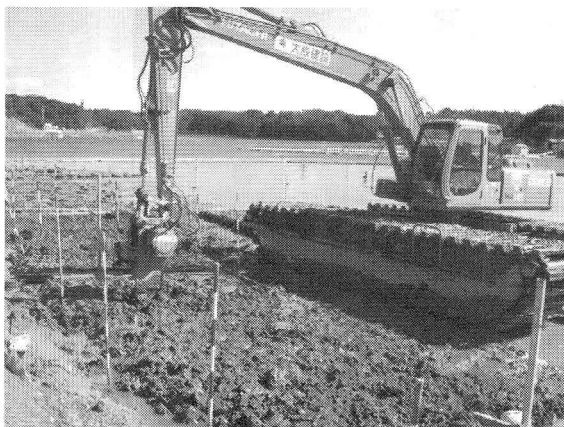
写真-2 ロータリースタビライザー付き 泥上車による現位置混合の状況
