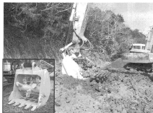
写真-3 攪拌バケット(ドライブミキシング) による混合攪拌の状況
