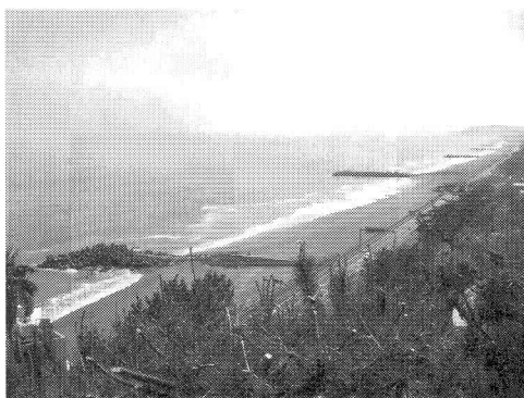
(a) 突堤群による海浜防護
