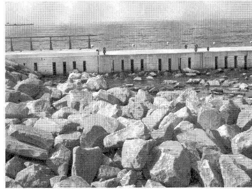
(b) 施工途中の護岸石積み部
