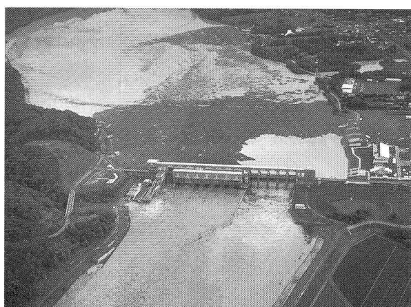
図-21 二風谷ダムにおける流木捕捉状況 7)
