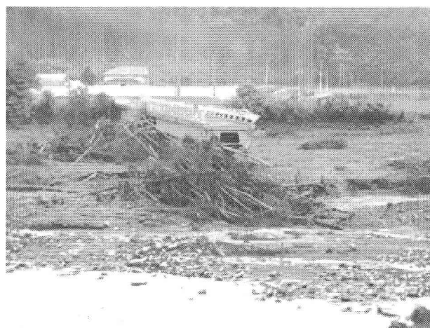
図-26 橋梁の被災状況(その1) 7)
