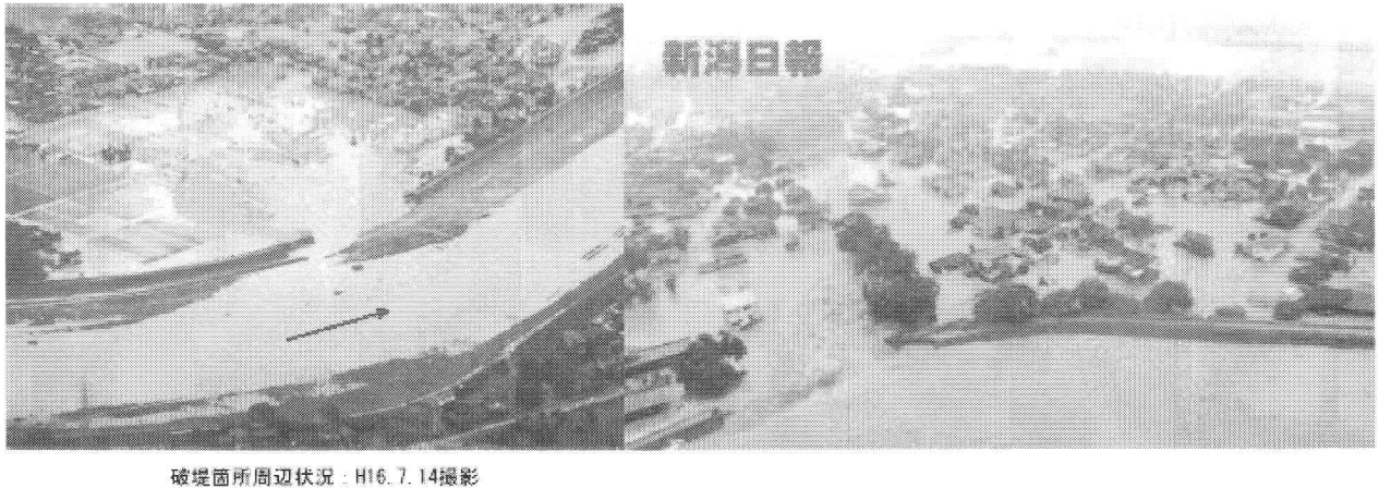
図－36 五十嵐川破堤状況（諏訪新田地区） 14) 図－37 刈谷田川破堤状況（中之島地区） 14)
