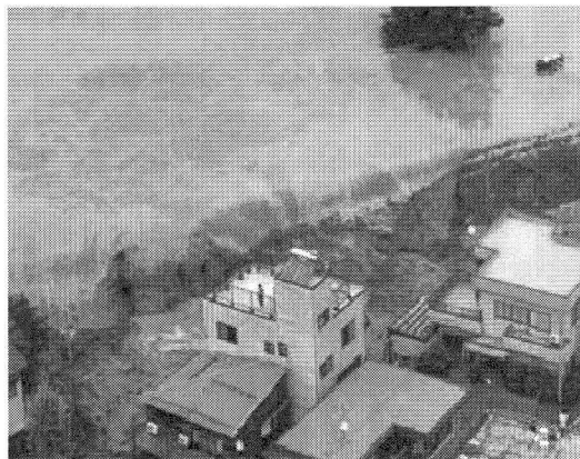
⑦集中豪雨で決壊した足羽川堤防＝18日午後1時20分、 福井市春日1丁目で、中日新聞社ヘリ「わかづる」から。（中日新聞社 提供）
