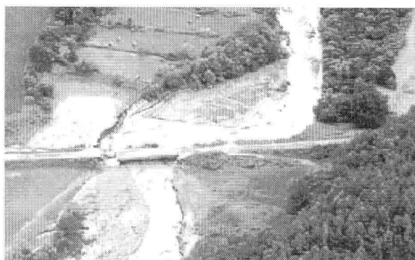
図-27 橋梁の被災状況(その2) 7)
