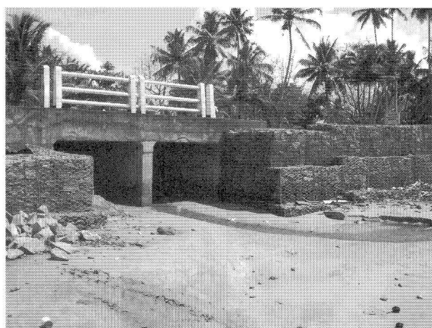
図-29 スリランカ津波による橋梁被災(その1) 図-30 スリランカ津波による橋梁被災(その2)
