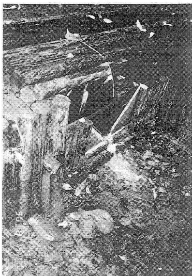
写真-3 藤舞試験地河川調査地点
