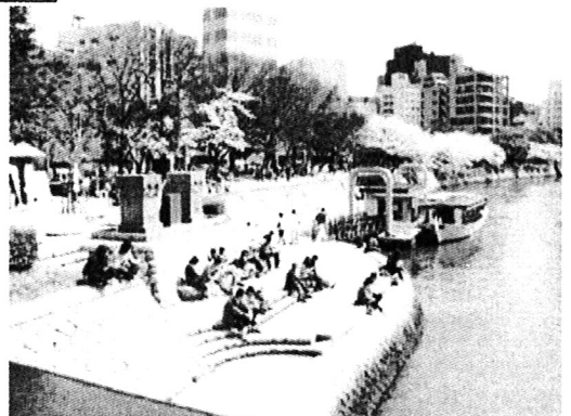
写真-13 橋詰の親水護岸
