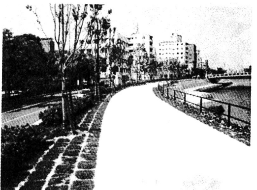
写真-23 太田川高潮堤防区間の盛土による植栽
