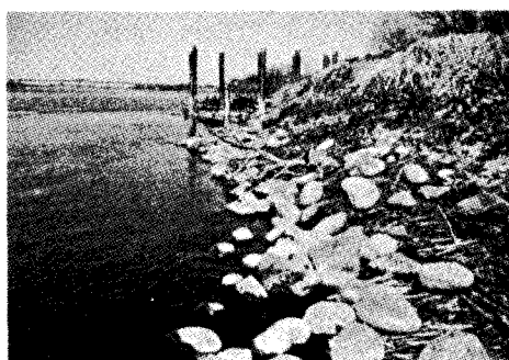
写真-7 旧水制や沈床詰石及び粗朶による河岸保護の状況 (2001.3)
