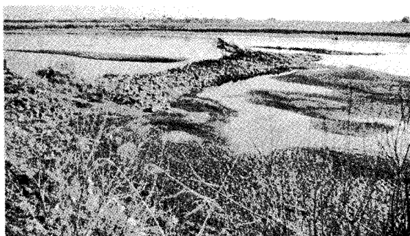
写真-6 旧水制の詰石が水制状に機能して上下流に土砂堆積など変化に富んだ水辺の状況 (134km) (2001.2)
