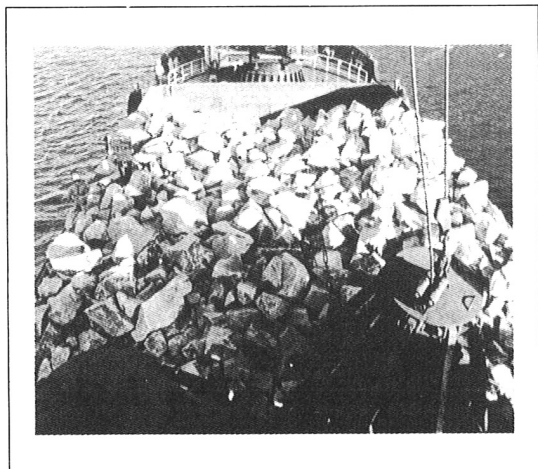
写真－4 捨石投入状況(1)
