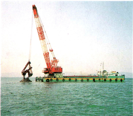
実験状況写真 H6投入状況
