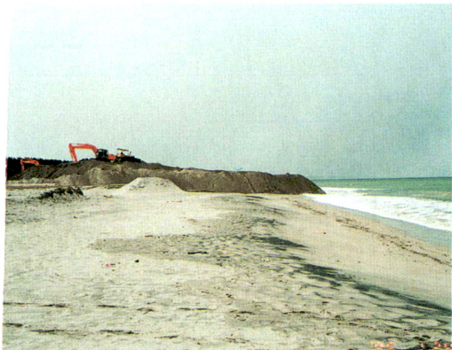
H7投入状況
