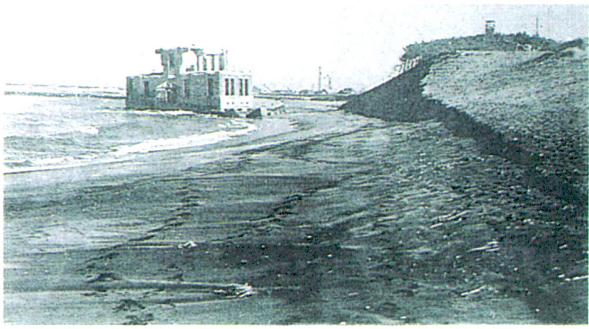
写真-2 S3年に水戸敷浜に建設された新潟県庁の水没状況 (S24年)
