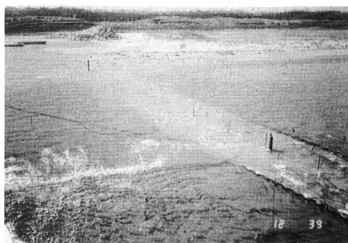
写真-6 干出した透水層埋設範囲
