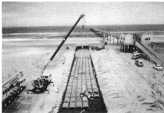
写真-4 透水層施工状況
