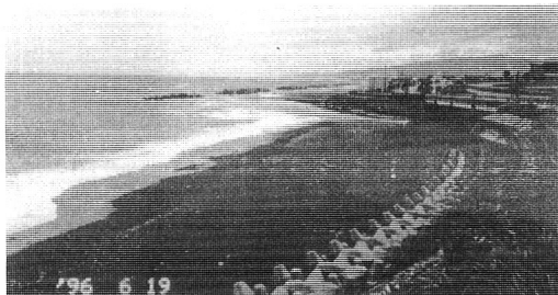
写真2 青梅川河口右岸の離岸堤群と左岸の堆積状況
