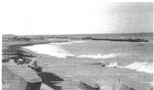
写真11 境川河口左岸の宮崎海岸西端と離岸堤群 (背後に土砂の堆積はない)
