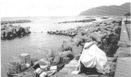
写真16 下新川海岸東端より約1kmの地点の護岸と離岸堤群
