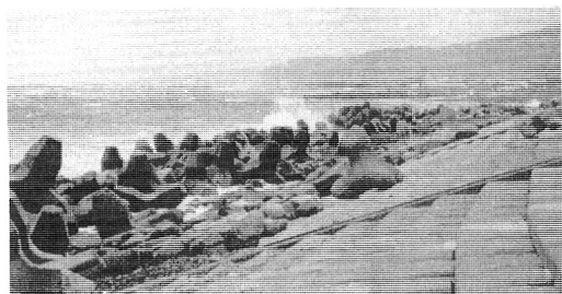
写真3 青梅川河口西海岸（勝山海岸）の緩傾斜堤と消波ブロック
