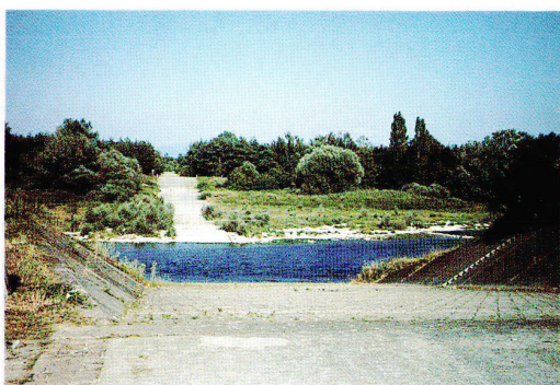
写真－３ 流量の減ったライン本川中流部
