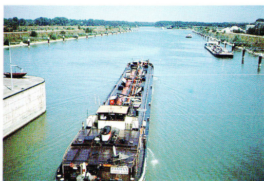
写真－２ ライン側岸運河開門部
