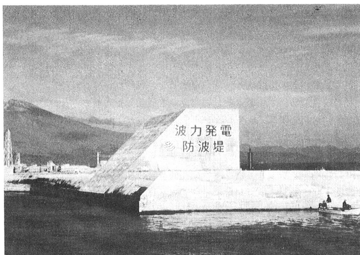
写真-1 波力発電ケーソン
