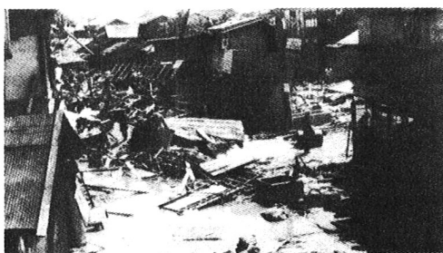
写真－４ 一関市街地の被害状況
