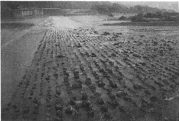
写真－１ 八田堰の粗石付き斜路
