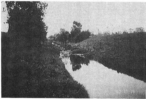
写真－７ Nefbach 工事前の姿
