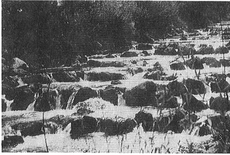
写真－５ Wildbach の巨石による落差工
