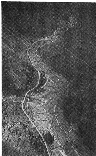
写真-11 称名川の床固工群
