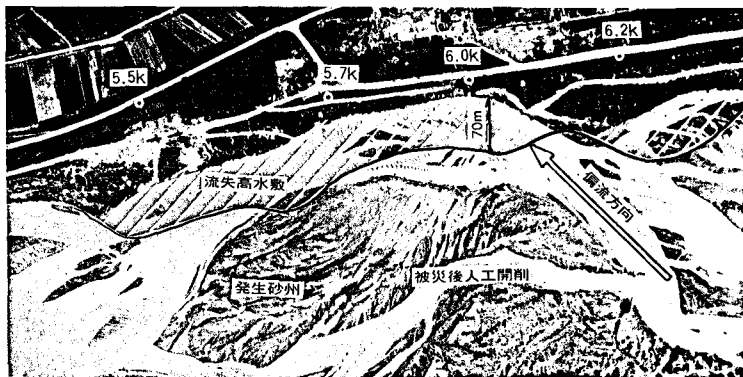
図-6 常願寺川の河岸決壊状況
