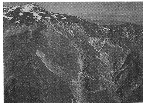
写真-9 手取川水源部の荒廃状況
