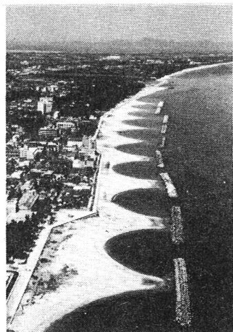
写真-6 皆生海岸における離岸堤（土木学会・海岸工学委員会スライド・ライブラリーより）
