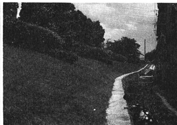
民家側の土堤裏を庭園化
