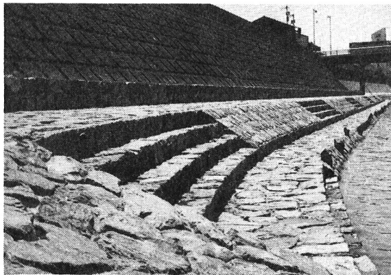
写真-2.1 愛媛県肱川の親水護岸(写真提供：建設省)
