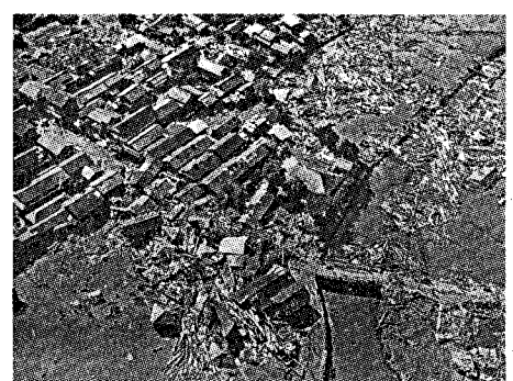
写真4. チリ地震津波、流木による家屋の被害(志津川) 3)
