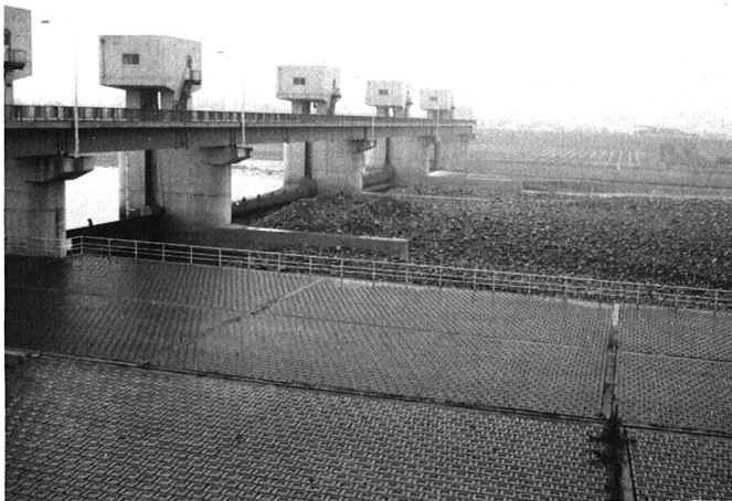
写真－6 太田頭首工下流の堆砂 (S.57 年洪水後, 三輪撮影)
