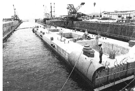
写真－7 完成した浮防波堤本体
