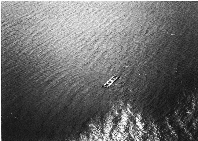
写真－1 浮防波堤の全景
