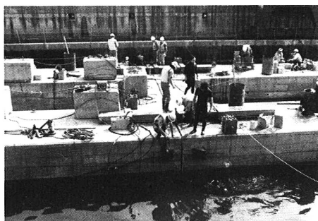
写真－5 仮接合作業
