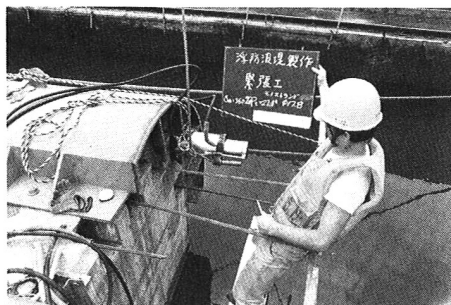
写真－6 PC 鋼線の緊張
