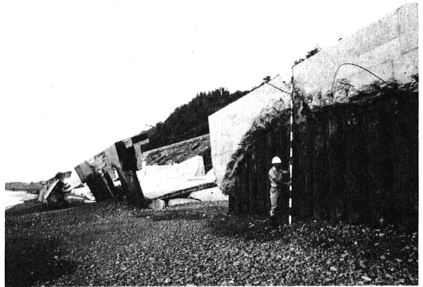
図-12 前浜のある所は鋼管基礎工は残った
