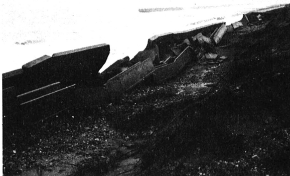
図-24 バットレス護岸被災(その2)
