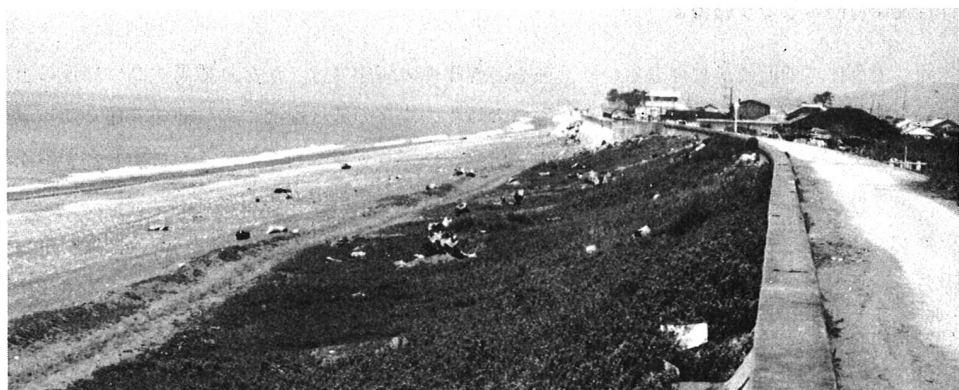
図-17 のり枠式堤防の最近の状況（昭和54年）
