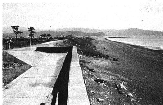
図-20 のり枠式と直立型の境界付近（昭和54年）
