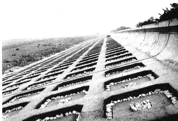
図-16 のり枠式堤防竣工当時（昭和44年）
