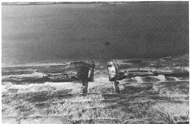
写真・2 サロマ湖第二湖口水路 （昭和53年12月6日撮影・網走土木現業所提供）
