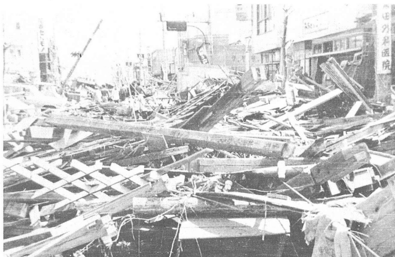
写真－5 チリ地震津波 大船渡町内の惨状
