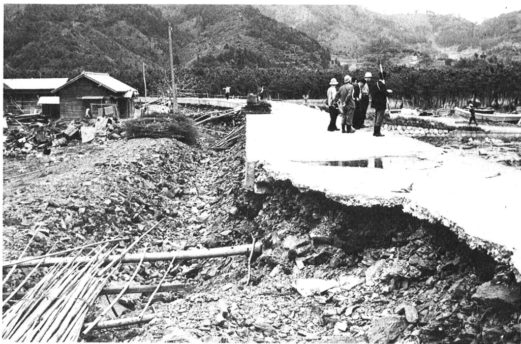
写真一四 大槌湾海岸堤防
