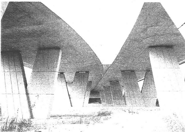
写真－４ ＰＩ－８高架橋
