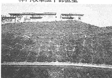
c2 緩斜面現場内法枠ブロック 枠内牧草風—1
