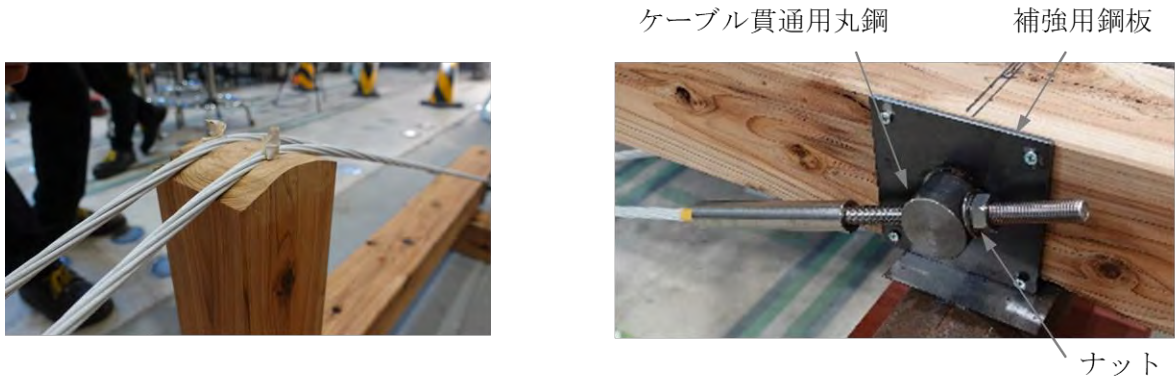
図-2 鉛直部材先端部
