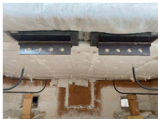
図-5 試験体の設置状況
