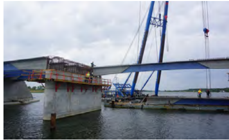
(c) プレキャスト複合桁の架設状況
