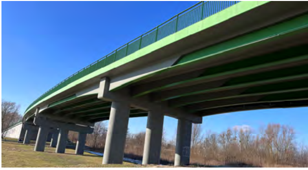
(a) 橋梁側面の外観
