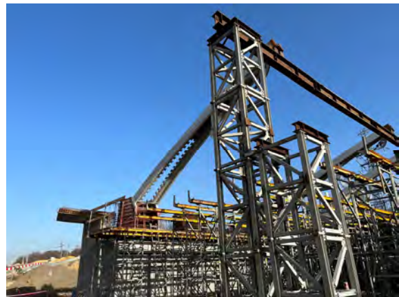
(d) アーチリブの架設状況
