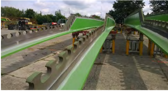
(c) 鋼桁およびクロソイド型ジベル
