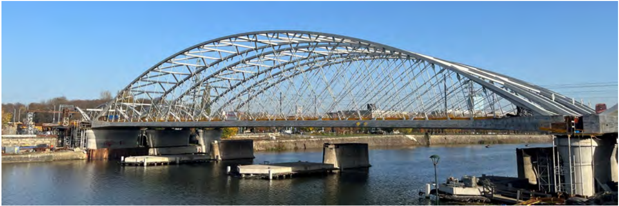
(a) 橋梁側面の外観（建設中）
