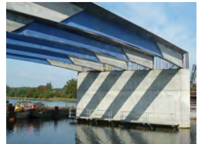
(d) プレキャスト複合桁架設後の状況
