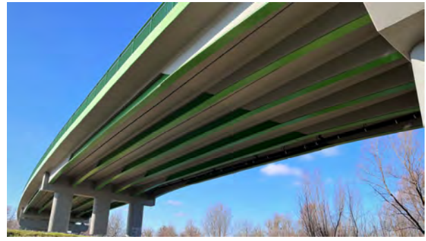
(b) 橋梁下面の外観
