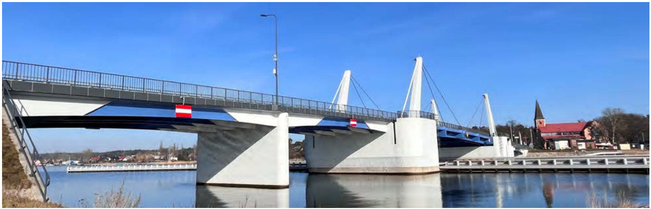
(a) 複合桁橋の外観
